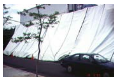
contención por atomización abrasiva
